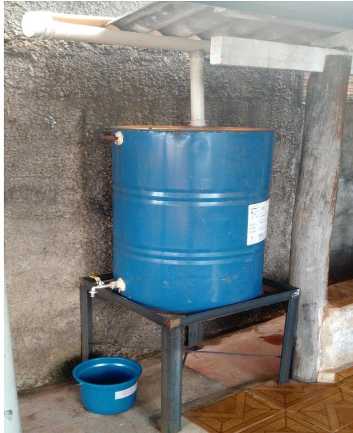
**Figura 2:** Reservatórios destinados a coleta da água pluvial.
